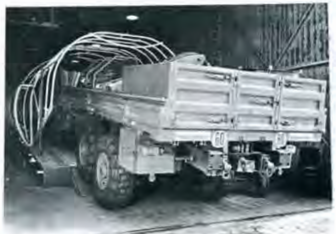
Étude d'aérotransport du TRM 10 000 sur Transall C. 160. Le TRM 10 000 est un véhicule tactique toutes roues motrices 6 x 6 (charge remorquable de 10 000 kg) ; il est utilisé pour tracter une pièce de 155.
